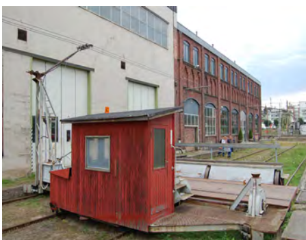
Jernbaneverksteder med travers, Espern-området på Hamar
