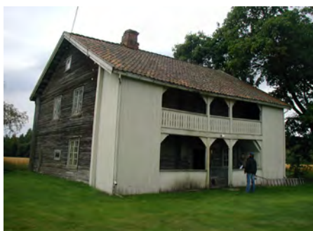
Bygning med svalgang på Vestre Nor
